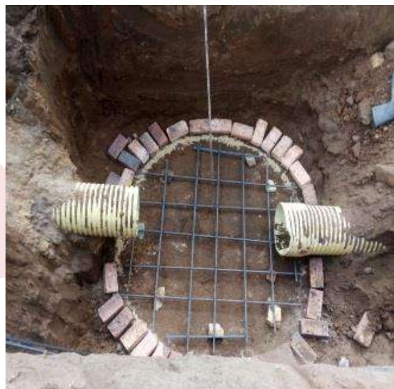
Ilustración 99. Instalación de tubería de alcantarillado, Calle 14 B con carrera 2
