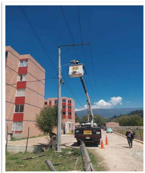
Ilustración 83. Instalación de luminarias
