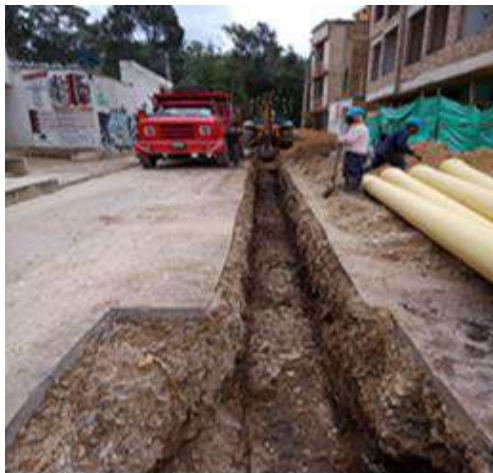
Ilustración 97. Reposición de alcantarillado, carrera 23 con calle 24
